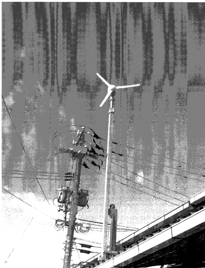
●風力発電 機械場の穴開け機の蛍光灯の電気を供給
